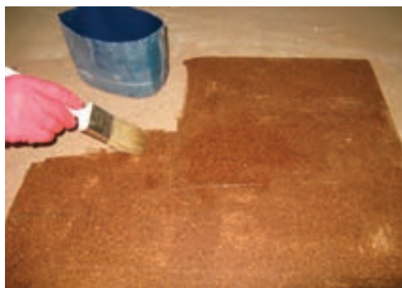
شکل ۴۹-۱۳- روغن اندود کردن سطح کار.
