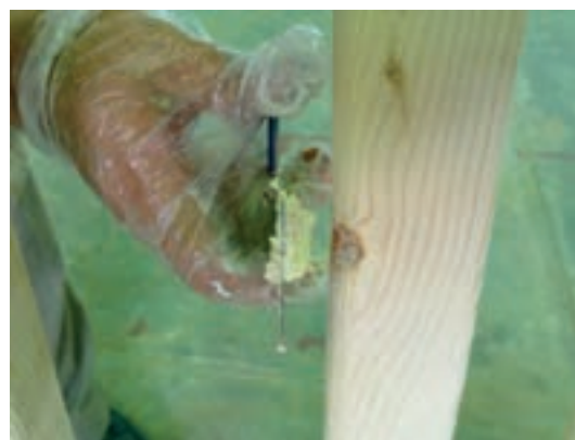
شکل ۶-۷- کاربرد بتونه سریشمی در سوراخ‌ها و شکاف‌های بزرگ.
