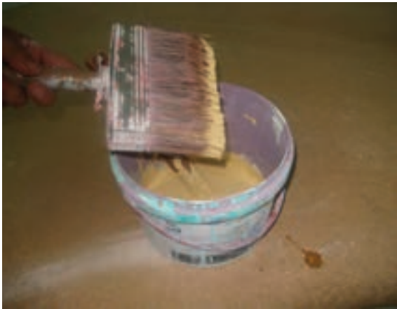
شکل ۵۶-۱۳- (رنگ‌کاری دیوار با قلم‌موی ساختمانی).
