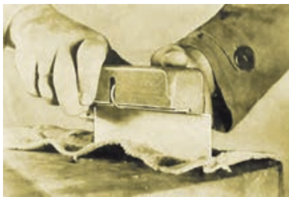
شکل ۳-۴۵- مصقل‌کشی نر لیس با رنده مصقل.
