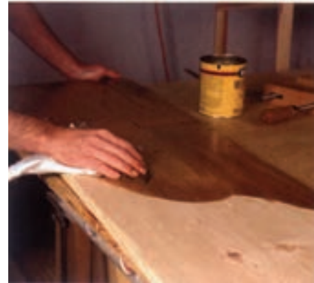
شکل ۱-۱۰- روغن اندود کردن سطح کار.
