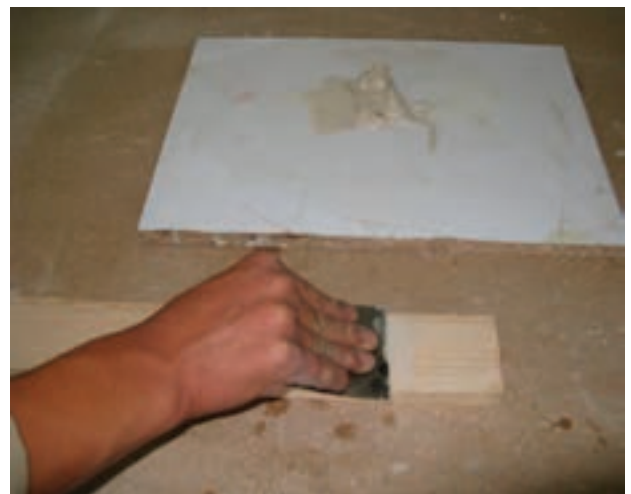
شکل ۵۹-۱۳- زدن بتونه هم‌رنگی به چوب نراد.
