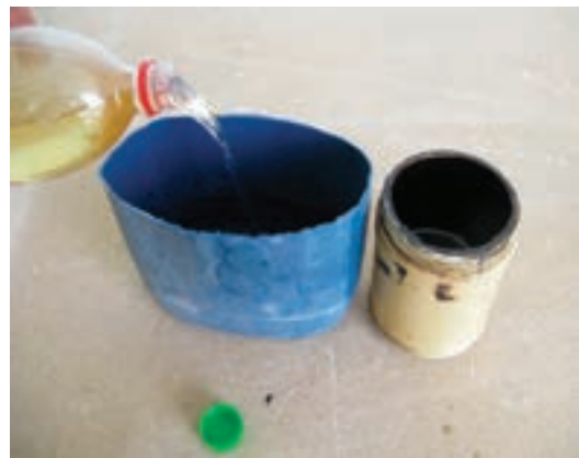
شکل ۶۳-۱۳- مل کردن آستری شاپان با نفت.
