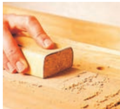
شکل ۱-۴- سنباده‌کاری با دست.
