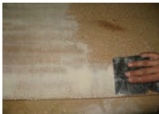
شکل ۳۱۵-۶- بتونه‌کاری نوع پوششی.
