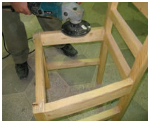
شکل ۳۷-۶- پرداخت کاری قبل از بتونه.
