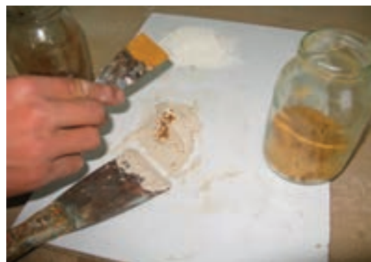
شکل ۳۲-۱۳- اضافه کردن پودر رنگی زرد به فمیر بتونه.
