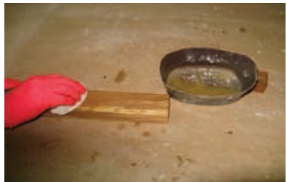
شکل ۳۸-۱۳- سیلرکاری با کهنه رنگ‌کاری.
