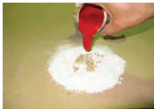
شکل ۲۴-۶- اضافه نمودن روغن الیف به بتونه روغنی.
