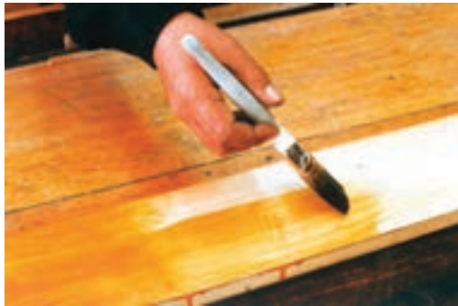
شکل ۳۴-۸- سیلرکاری در جهت الیاف.
