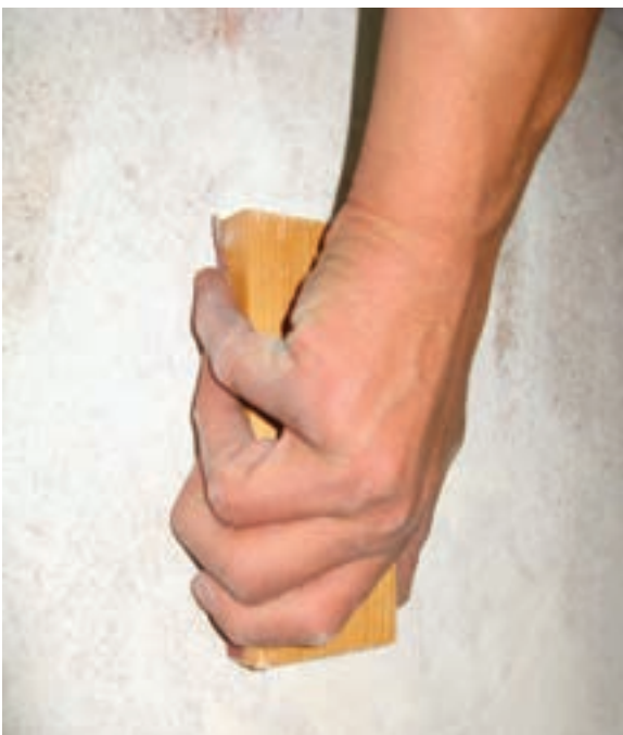
شکل ۱۹-۱۱- سنباده کاری سطوح ماستیک کاری شده.
